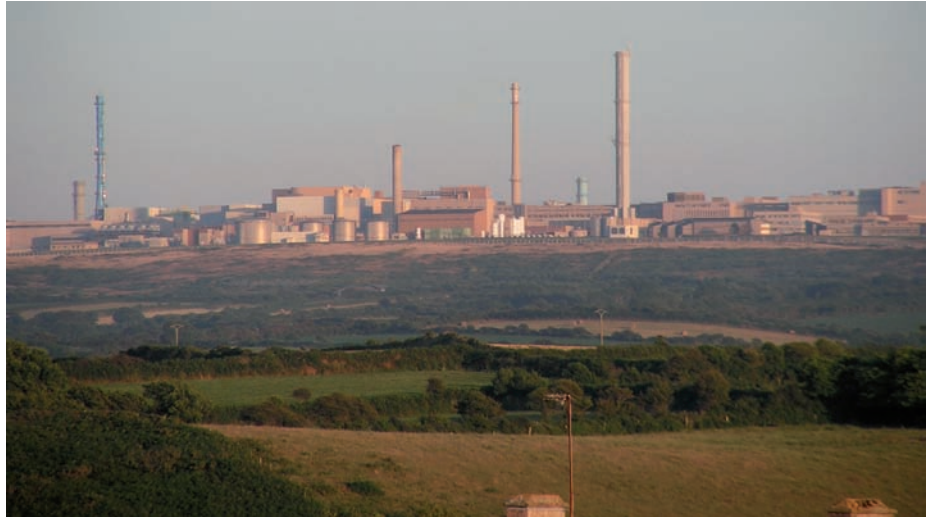
Abgebrannter Kernbrennstoff enthält etwa 96% Uran, 1% Plutonium und 3% Abfallstoffe (Spaltprodukte). Die Trennung dieser Bestandteile erfolgt in einer Wiederaufbereitungsanlage. In Frankreich sind zwei solcher Anlagen (UP2-800 und UP3) am Standort La Hague in Betrieb (Foto). Sie sind speziell für die Wiederaufbereitung von oxidischem Brennstoff aus Leichtwasserreaktoren ausgelegt. Die Anlage UP2-800 ist für den französischen Bedarf, UP3 für die Wiederaufbereitung ausländischer Brennelemente vorgesehen.
